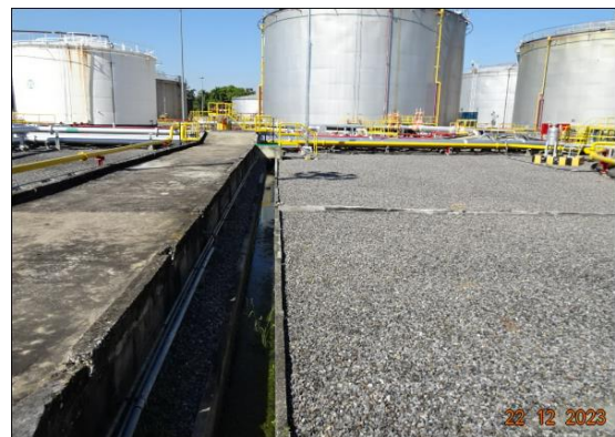
ภาพที่ 3 รางระบายน้ำภายในโครงการ
